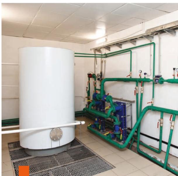
В теплоузле мойки реализована схема подготовки горячей воды с использованием бойлера косвенного нагрева объемом 2000 литров. Такая технология нагрева применяется в Компании впервые.
