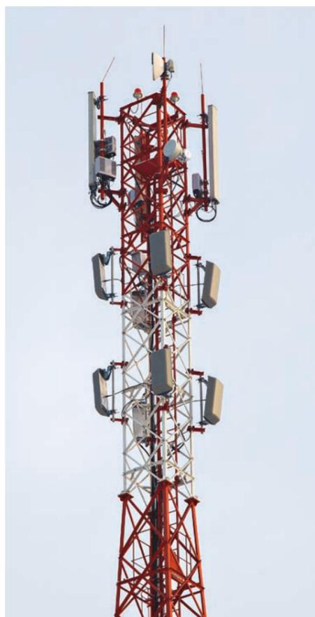
← На вышках сотовой связи дополнительно установили антенны цифровой радиосвязи стандарта DMR (Digital Mobile Radio) Tier III и модули с оборудованием
