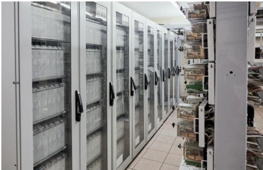
Рис. 2. Шкафы с аппаратурой БМЦ-М на станции «Митино» после завершения опытной эксплуатации. Справа — стивы с реле существующей ЭЦ
