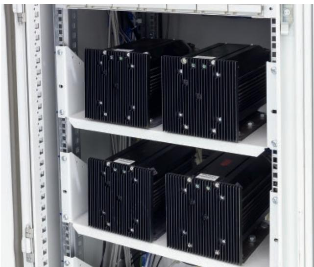
Рис. 4. Модули централизации и блокировки системы БМЦ-М
